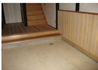
床材に桧板を使用したリフォーム例
