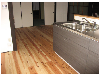
キッチンの床材に杉のフローリングを使用した例
