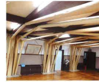
北山丸太を使用した耐震改修
