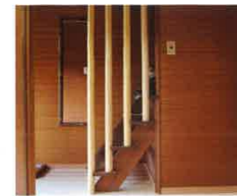
階段の飾り柱として北山杉小丸太を使用
