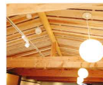
店舗の天井に北山丸太と杉板を使用
