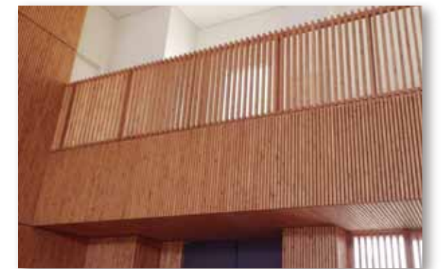
壁面ルーバー
