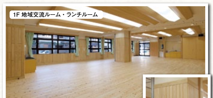
床材は桧板を使用
