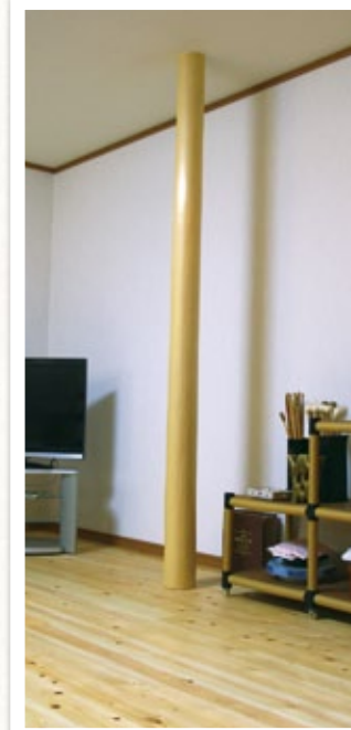
桧のフローリングと北山磨丸太を使用し落ち着いたリフォーム
