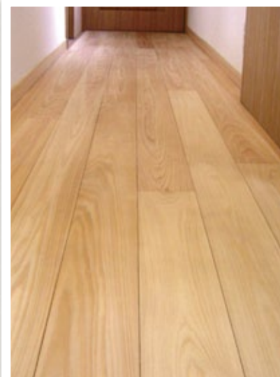
桧板を使用した廊下
