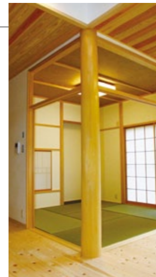
床に桧、天井には杉、方立柱に北山丸太を使用
