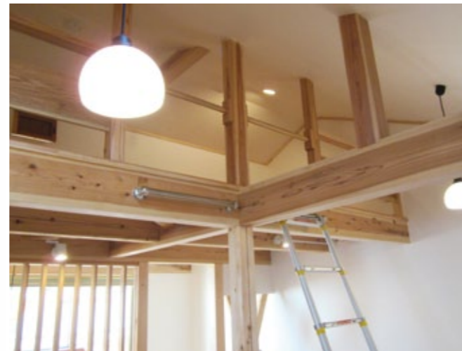
梁や柱等の構造材に杉、桧を使用
