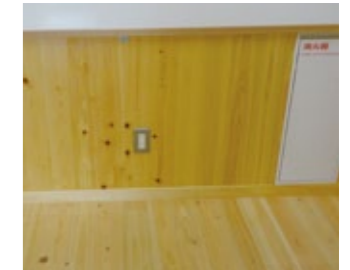
床、壁に桧を使用
