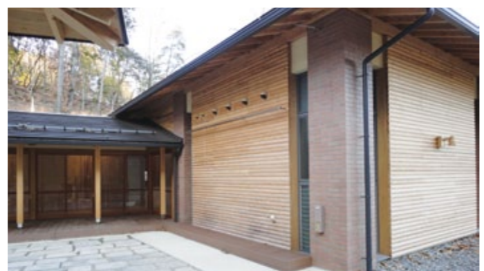
外壁に杉を使った野外学習棟
