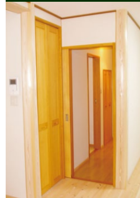
リビングの柱に北山丸太(面皮柱)を使用
