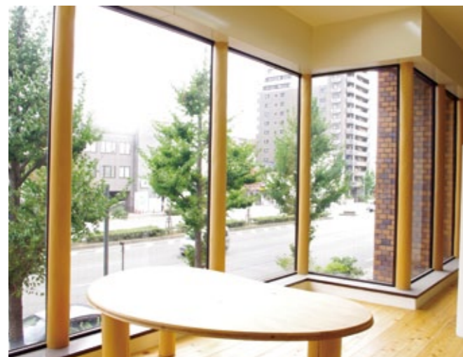
窓フレームを北山丸太で装飾したオフィスリフォーム
