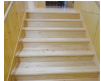
階段板、壁に桧を使用
