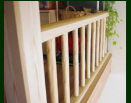
ロフトに北山丸太(面皮柱、タルキ)を使用
