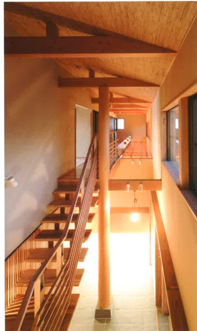
北山丸太を大黒柱として使用した玄関ホール ※空間工房 用舎行蔵 一級建築士事務所提供
