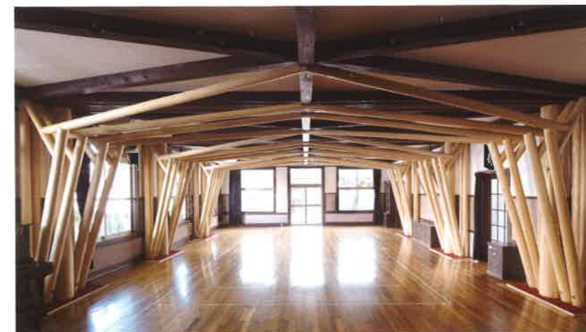
北山丸太を耐震改修に使用した例 ※株式会社 SOL 一級建築士事務所提供
