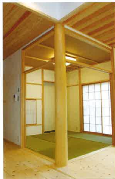
方立柱に北山丸太を使用した例 ※株式会社竹内工務店提供
