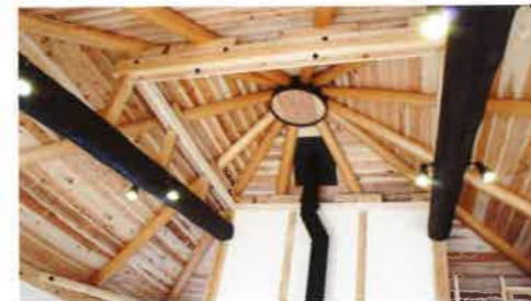
北山丸太を構造材として使用した研修施設 ※株式会社里仁舎協力
